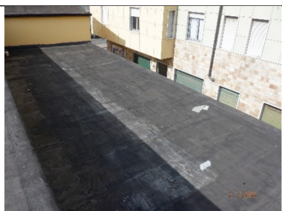
Guaine bituminose sul tetto piano al livello intermedio della copertura
