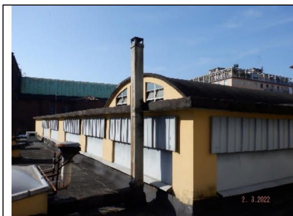
Comignolo in fibrocemento sul tetto piano al livello intermedio della copertura
